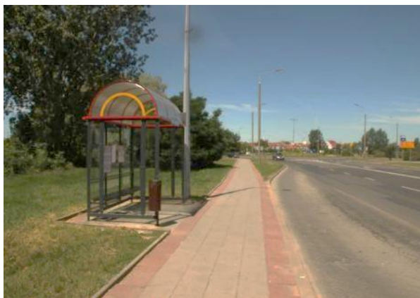
Fotografia 81 Przykład przystanku autobusowego w dobrym stanie technicznym
