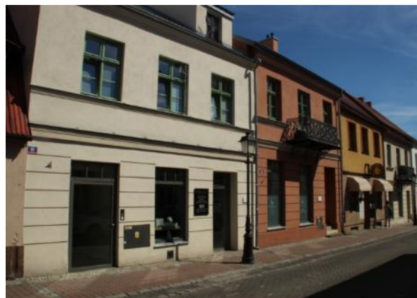
Fotografia 106 Budynki komunalne przy ul. Wiosny Ludów 11, 13, 15
