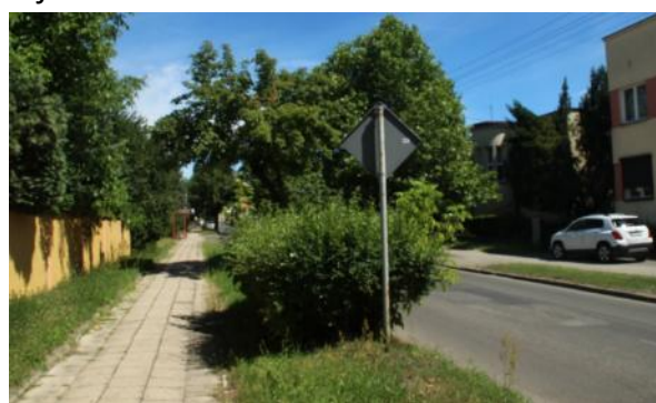
Fotografia 126 Przebieg chodnika w przeciętnym stanie technicznym w rejonie ul. Staszica
