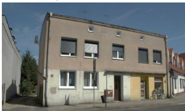
Fotografia 110 Zmodernizowany budynek wspólnoty mieszkaniowej przy ul. Kilińskiego 6
