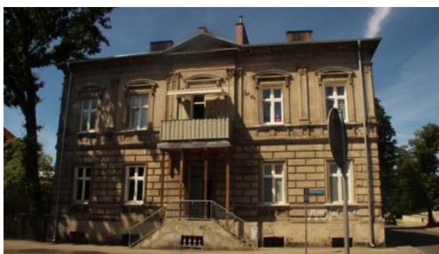
Fotografia 116 Budynek mieszkalny przy ul. Kilińskiego 2 o nieuregulowanej własności
