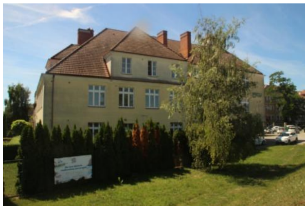
Fotografia 13 Budynek CKU przy ul. Wodnej 1
