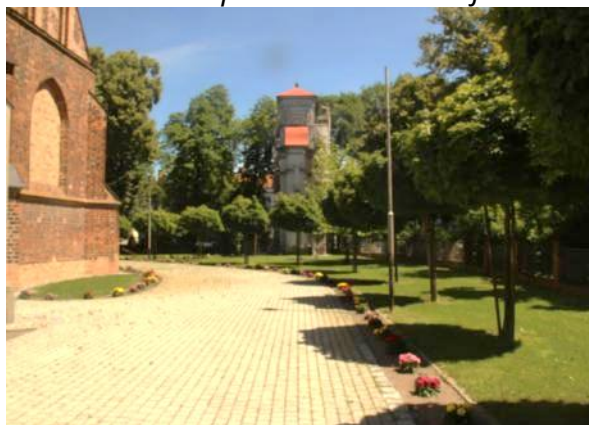
Fotografia 35 Przebieg ciągu pieszego wokół Kościoła pw. Św. Bartłomieja
