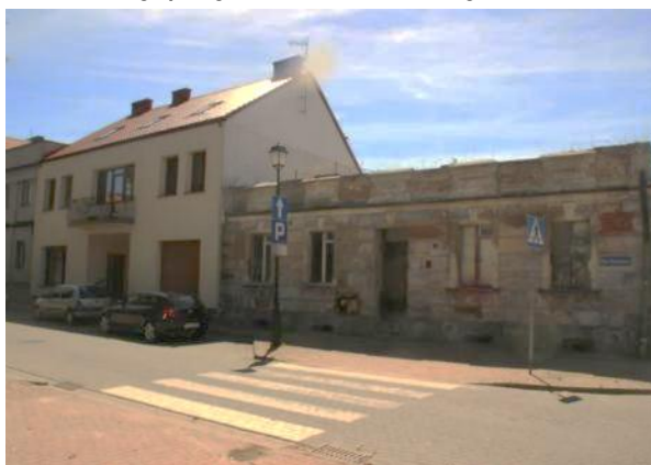
Fotografia 95 Przykład zdegradowanego budynku i obok niej odnowionej kamienicy przy Placu Zamkowym
