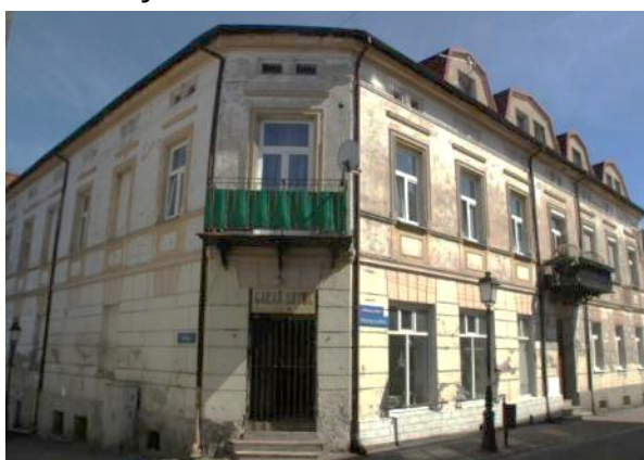
Fotografia 107 Budynek komunalny przy ul. Wiosny Ludów 1
