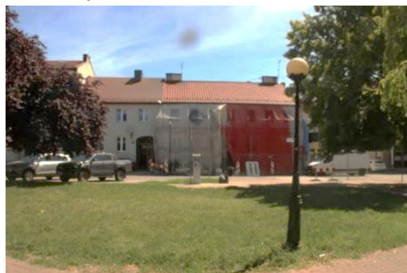
Fotografia 100 Budynek przy Placu Zamkowym 7 – w trakcie remontu
