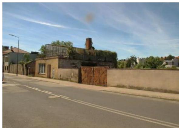
Fotografia 96 Przykład zdegradowanego budynku przy ul. Obrońców Westerplatte
