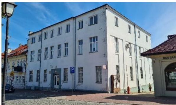
Fotografia 20 Budynek Urzędu Miejskiego po dawnym Sądzie Rejonowym przy ul. Wojska Polskiego 2
