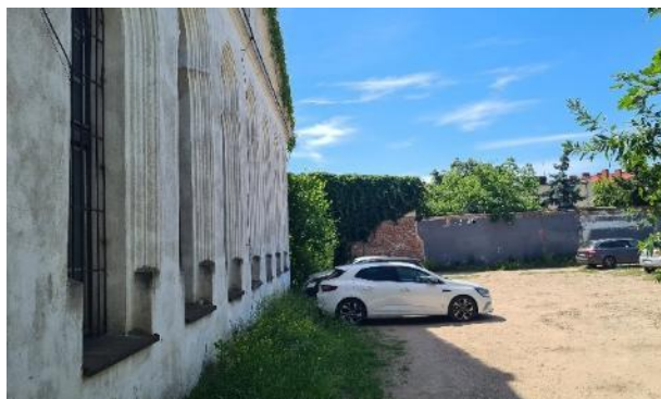
Fotografia 49 Niezagospodarowane otoczenie synagogi
