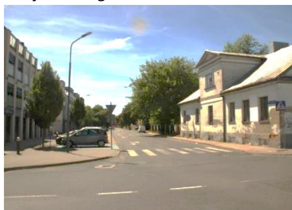
Fotografia 130 Stan techniczny ul. Wodnej, pomiędzy ul. Kościelną a Szarych Szeregów
