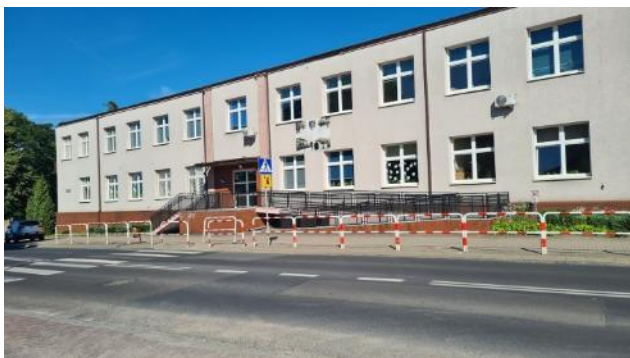
Fotografia 10 Budynek, w którym mieści się Specjalny Ośrodek Szkolno-Wychowawczy, przy ul. Kaliskiej 19 (część północna)
