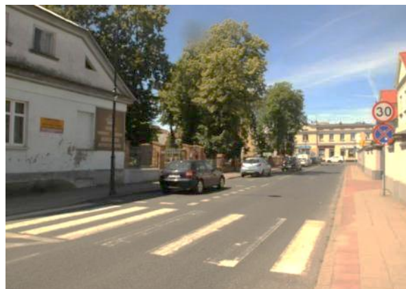
Fotografia 128 Stan nawierzchni jezdni ul. Kościelnej
