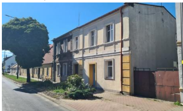
Fotografia 102 Budynek komunalny przy ul. Kolskiej 27
