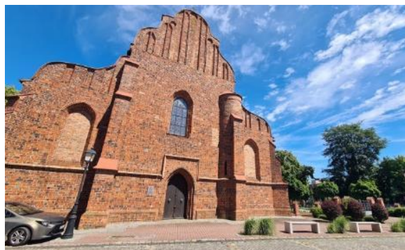
Fotografia 33 Widok na Kościół pw. Św. Bartłomieja, w tle skwer
