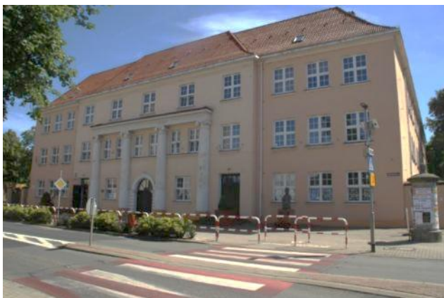
Fotografia 6 Budynek Szkoły Podstawowej nr 1 przy ul. Kolskiej
