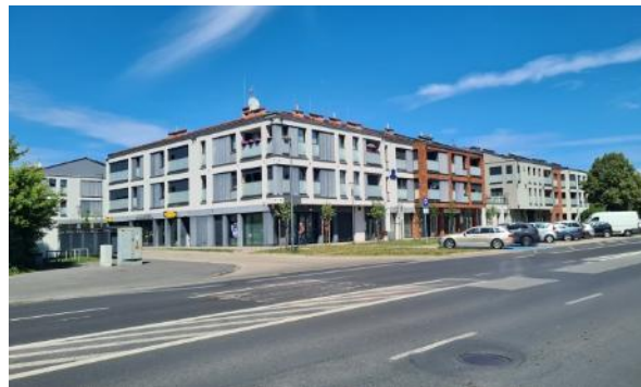
Fotografia 66 Budynek MTBS przy ul. Szarych Szeregów 2G, 2F
