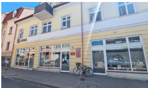
Fotografia 14 Budynek filii Miejskiej Biblioteki Publicznej przy ul. Urbanowskiej 1
