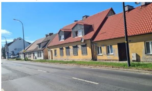
Fotografia 101 Budynki komunalne przy ul. Kolskiej 23, 25
