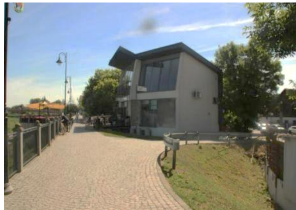
Fotografia 31 Widok na punkt gastronomiczny przy Bulwarze Nadwarciańskim
