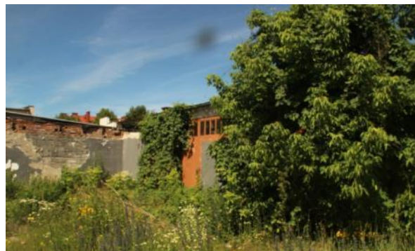
Fotografia 124 Zdegradowane otoczenie w pobliżu synagogi przy ul. Mickiewicza
