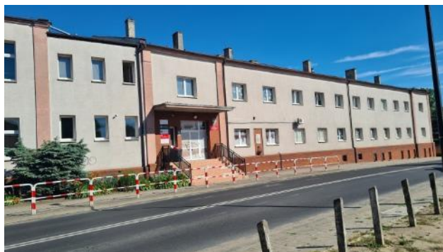
Fotografia 11 Budynek, w którym mieści się Specjalny Ośrodek Szkolno-Wychowawczy, przy ul. Kaliskiej 19 (część południowa)
