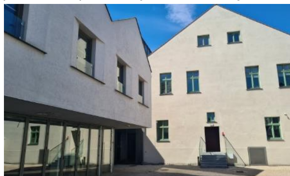
Fotografia 43 Zagospodarowana przestrzeń przed wejściem do budynku
